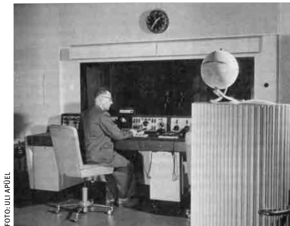
▲ Der Willisen Rundumstrahler von 1955 verfügte über zwölf Hochtonchassis in der Kugel. Die tiefen Töne entstanden im Schrank darunter.
